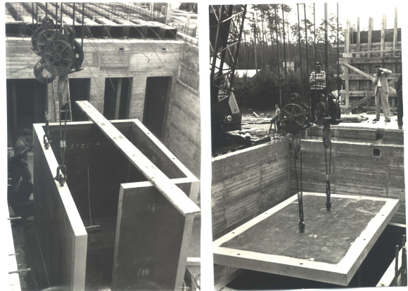
Aufbau der Abschirmkammer aus Stahlplatten
